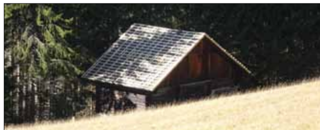
Neueindeckung der Schupfe/Stadl an der Goste durch Fam. Goller, vlg. Untergoll, Bergen 11
