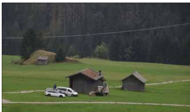
Neueindeckung der Schupfe am Goldsteig durch Fam. Ausserhofer, vlg. Darmer, Dorf 100
