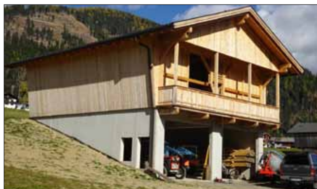
Neubau des Stadels am Mühlweg durch Fam. Ebner, vlg. Draschler, Dorf 12
