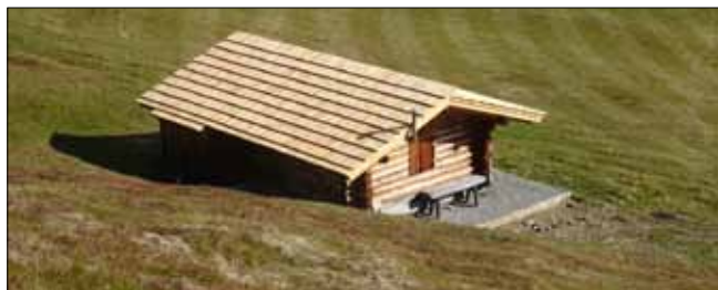
Neueindeckung der Schupfe am Glamp durch Fam. Scherer, vlg. Wastinger, Dorf 69
