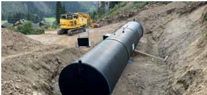
Der hohe Vorfertigungsgrad ermöglicht kurze Bauzeiten
